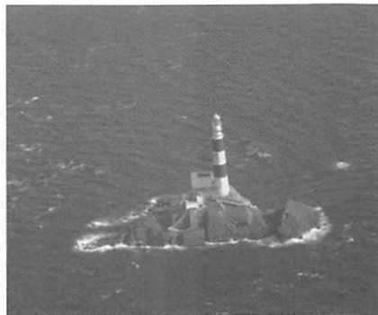
上空から見る水ノ子島燈台
